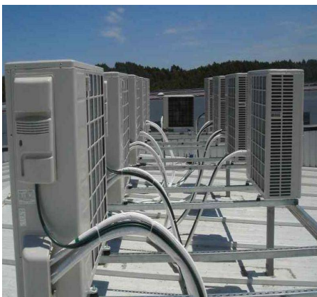
Instalación de condensadoras en terraza
